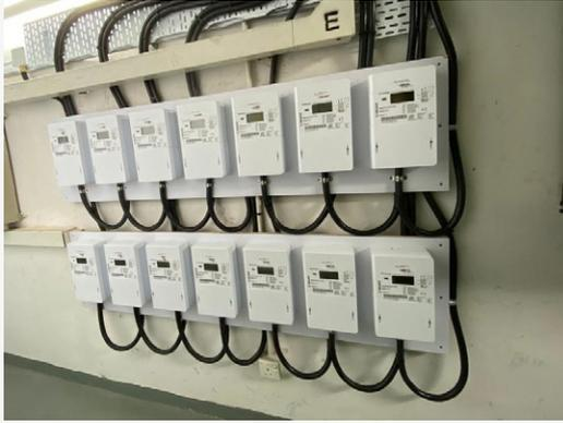
開拓節能機遇的最佳方法是監察「環境績效約章」參與租戶的能源表現並分析他們的用電模式。我們於2023年底開始為辦公樓租戶配置主電路監控系統。本系統除可收集詳細的用電數據，還可提供關於租戶用電強度以及辦公時間與非辦公時間的用電量比率的資料，此外亦便利租戶與我們分享用電數據，毋須人手輸入，以便進一步分析。截至2024年12月31日，我們已為約60%「環境績效約章」辦公樓租戶安裝主電路監控系統。
