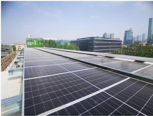
太古地產位於三里屯太古里N15廣場大樓和紅館的綜合太陽能、儲能、直流配電及柔性用電系統現已投入運作。現場實施工作已於2023年中完成，並於2024年初在地下停車場安裝了PEDF連接樞紐及兩座雙向電動車充電器。雙向電動車充電器採用車對樓 (V2B) 技術，高峰負載時段或停電時，電動車內置的電池可向物業供電，同時確保工作日結束後電動車可充滿電。
